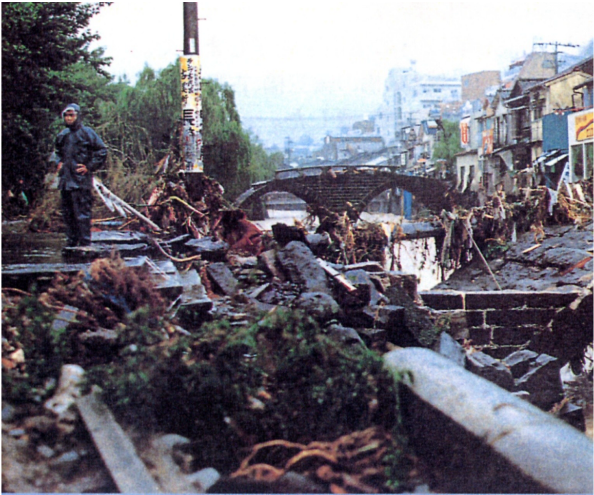
写真 2-2 眼鏡橋付近の災害状況 提供：長崎県長崎土木事務所
