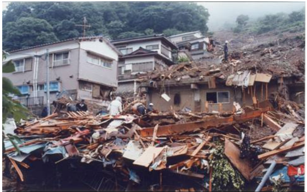
写真2-1 鳴滝町の土砂崩れ現場(提供:DEITz株)
